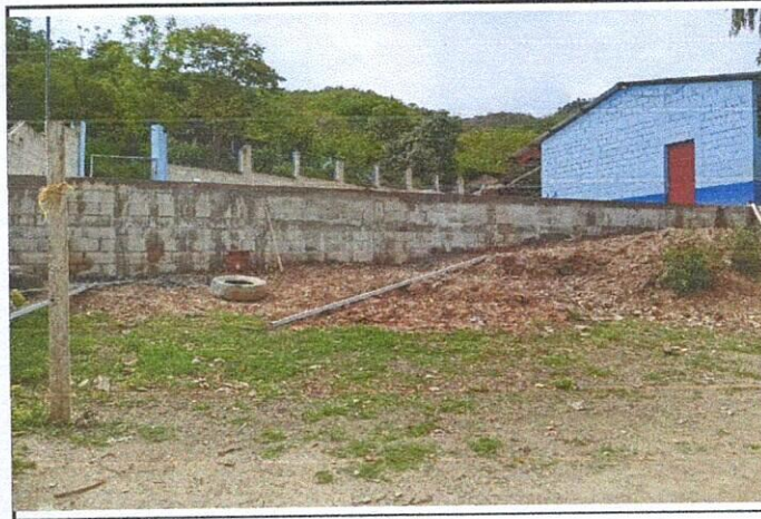
Foto 4: Reparación de muro de contención
