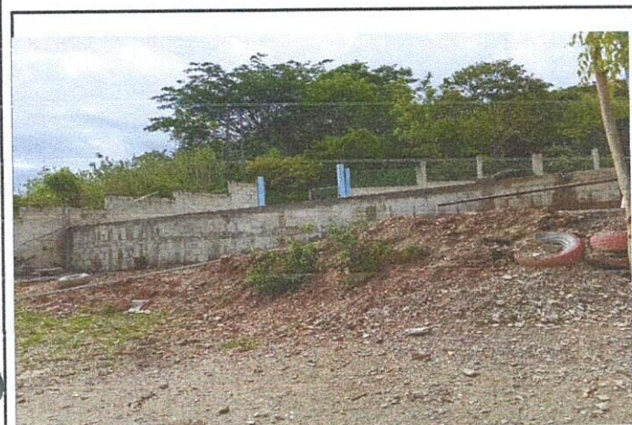
Foto 3: Reparación de muro de contención
